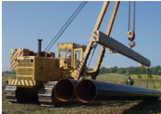
Рисунок 1 - Трубоукладач "Komatsu" D-355
