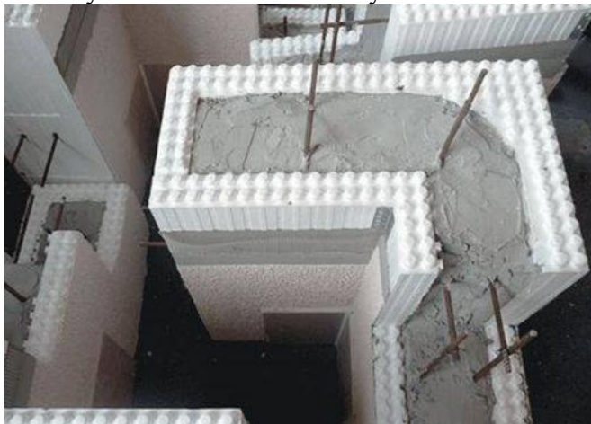
Рисунок 5 – Будинок за технологією будівництва з незнімною опалубкою
