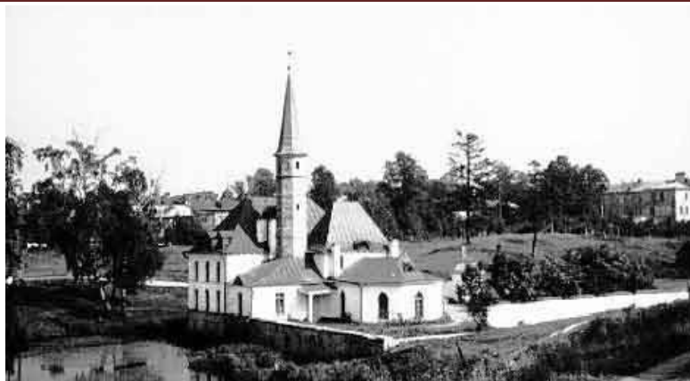
Рисунок 3 – Будівництво будинку з ґрунту
