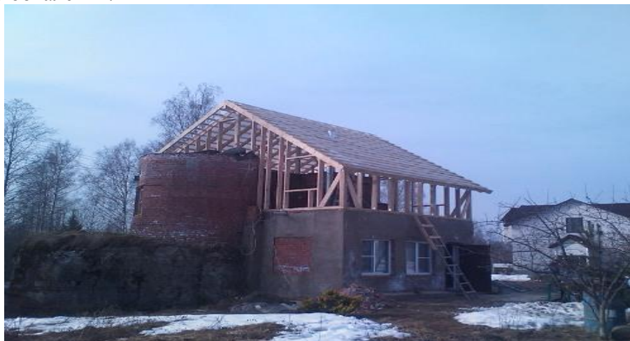
Рисунок 4 – будівництво мансарди над вже існуючим будинком
