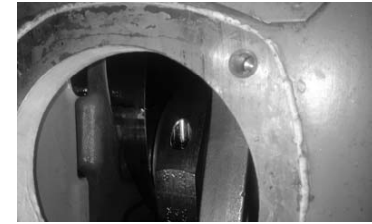
Рисунок 3 - Вид коленчатого вала двигателя Jenbacher 420 после поломки
