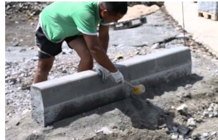
Рисунок 6 – Процес встановлення та виставлення дорожнього бордюру
