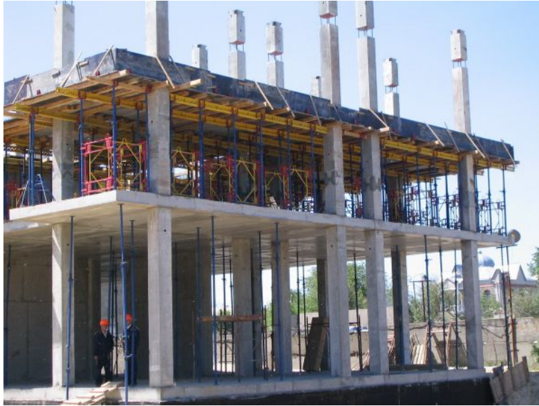
Рисунок 8 – Демонтаж підтримуючих пристроїв і перестановка їх для улаштування перекриття наступного поверху.
