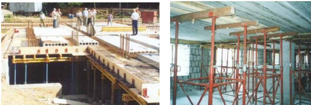
Рисунок 6 – Підтримуючі пристрої і плити перекриття укладені в проектне положення
