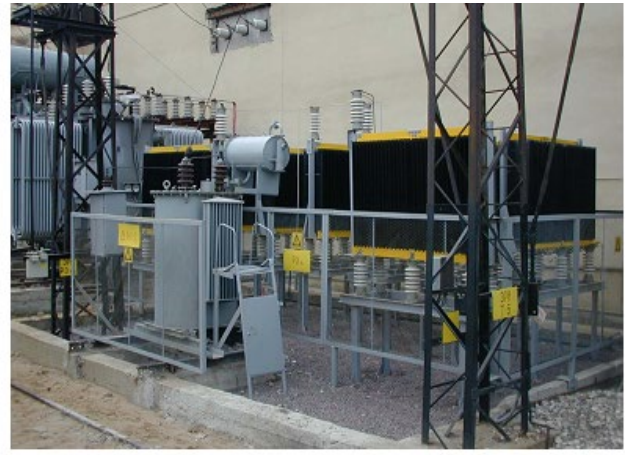
Рисунок 2 а) резистори РЗ- 800-15-6 в ме режі 6 кВ б) резистори РЗ-4000-102-35 на ВРП-35 кВ
