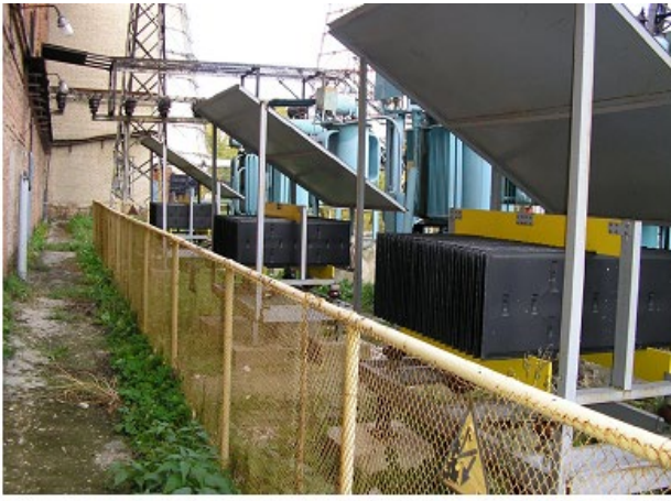
Рисунок 2 а) резистори РЗ- 800-15-6 в ме режі 6 кВ б) резистори РЗ-4000-102-35 на ВРП-35 кВ
