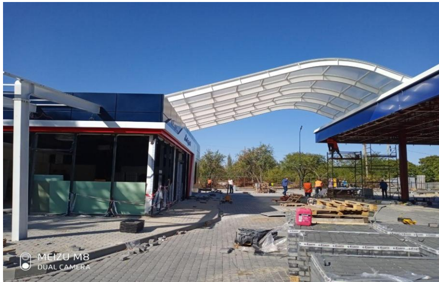
Рисунок 1 - Металевий каркас пункту сервісного обслуговування водіїв та пасажирів автотранспорту в селище Нове м. Кропивницький
