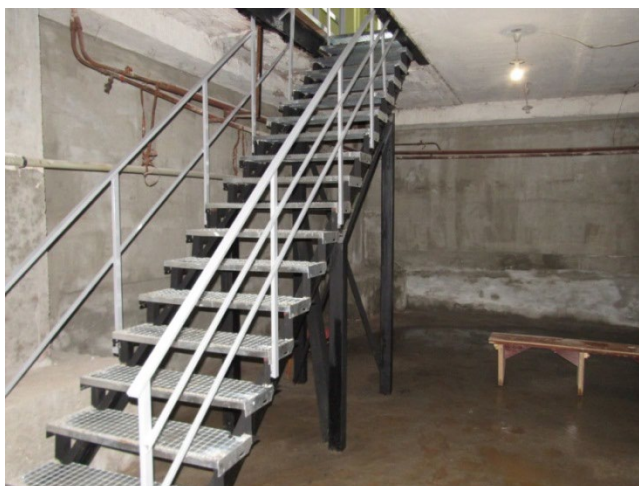
Рис. 15 – Виготовлені сходи евакуаційного виходу з укриття у навчальному корпусі №2
