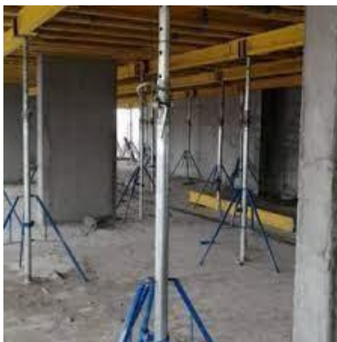
Рисунок 2 – Загальний вигляд горизонтально опалубки для бетонування монолітного перекриття
