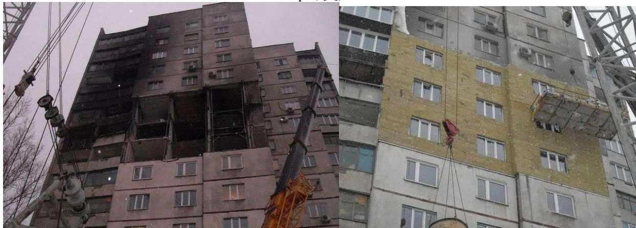
Рисунок 2 – Наслідки вибуху природного газу в шістнадцятиповерховому панельному будинку і загальний вигляд відновленого фасаду [9]
