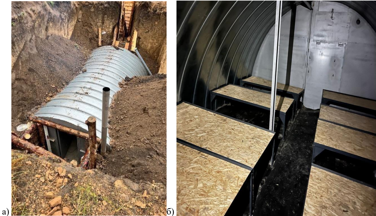
Рисунок 2 – Металеве бункер-сховище: а) монтаж, б) вигляд всередині
