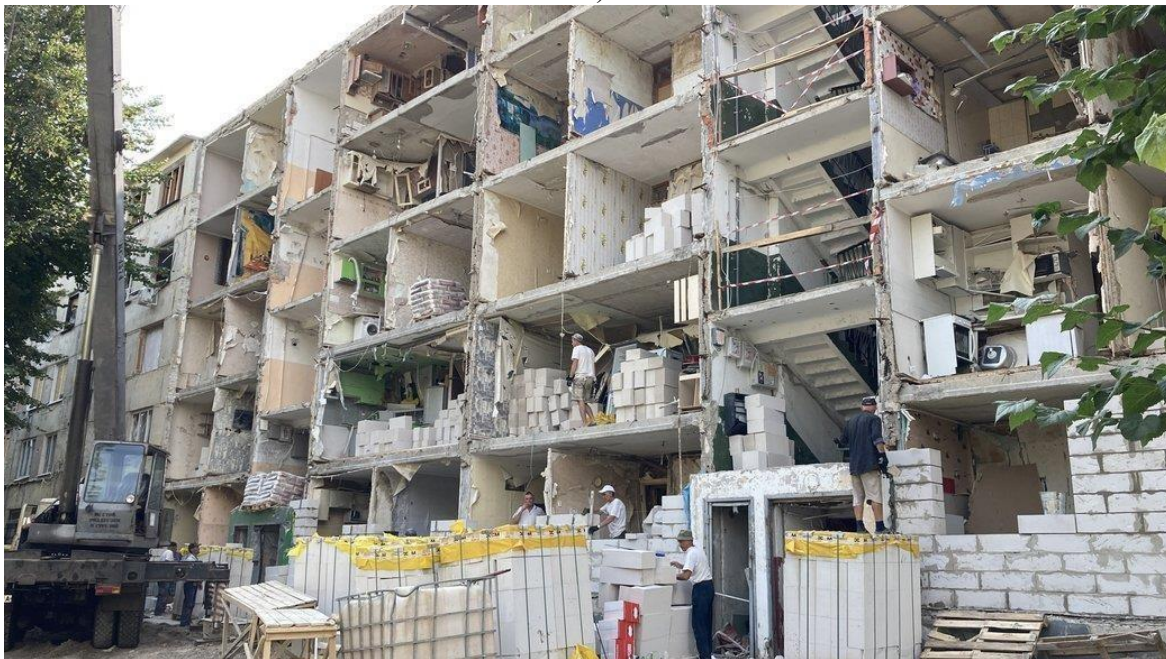
Рисунок 3 – Відновлення будинку із великопанельними зовнішніми стінами (джерела: а – www.unian.ua , б – з сайту suspilne.media )
