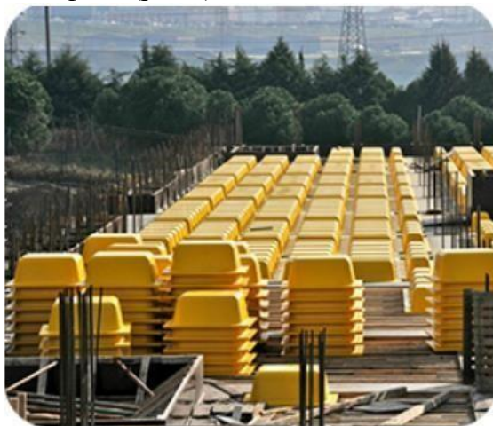
Рисунок 1 – Загальний вигляд опалубки для кесонного монолітного перекриття
