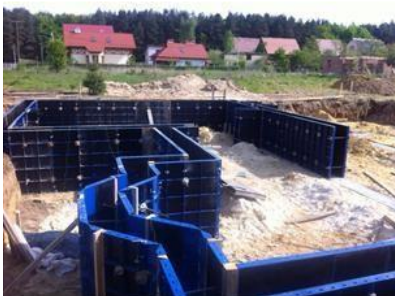
Рисунок 1 – Загальний вигляд вертикальної опалубки для зведення будівель монолітного типу
